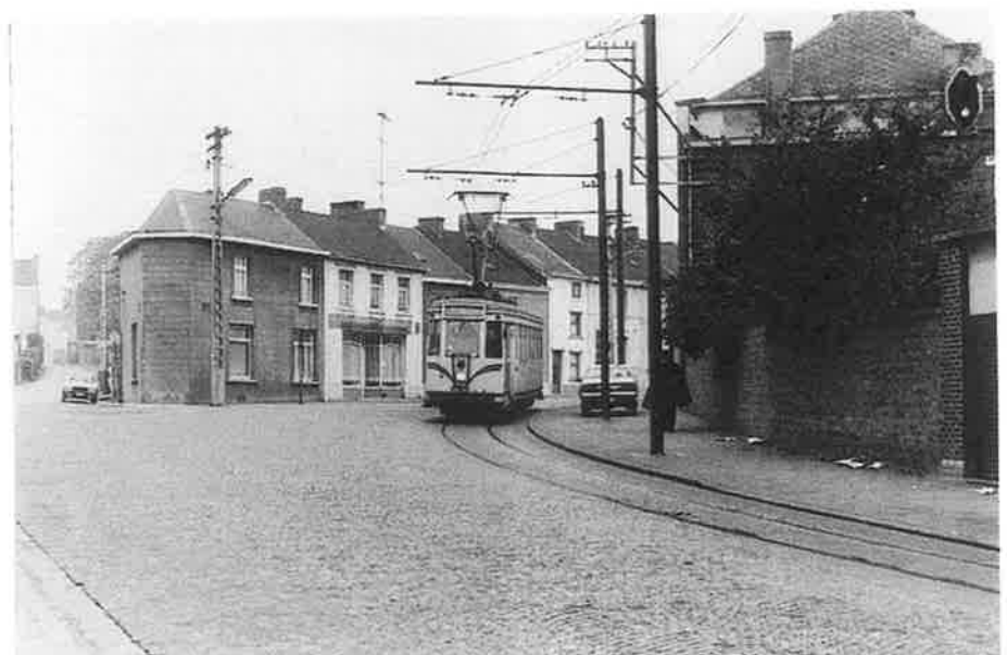
Foto 6 Jumet Heigne, 1978. Wellicht het enige lijnstuk met bovenleidingmasten.
